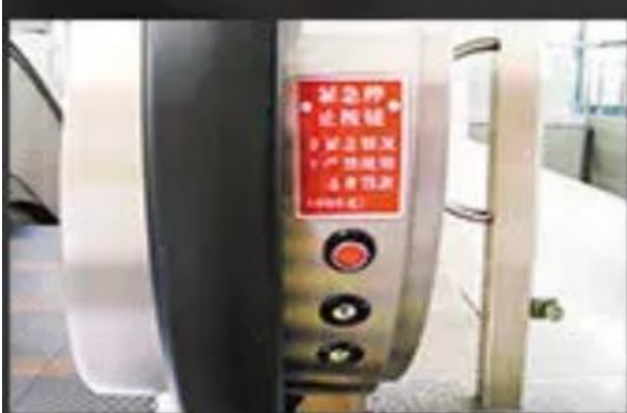
1、电梯入口扶手处 ↑
