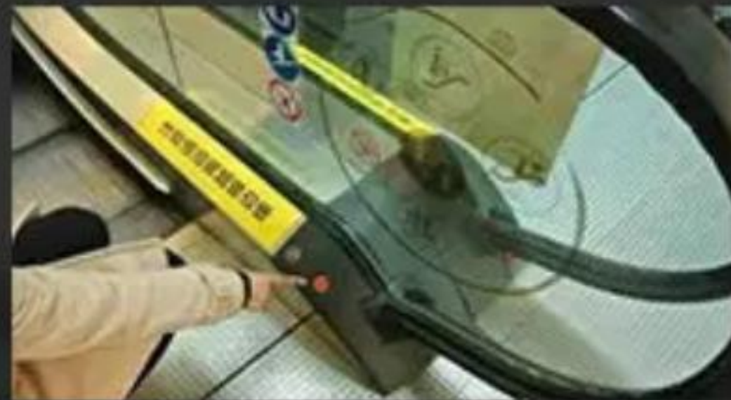
2、电梯内侧盖板底部 ↑
